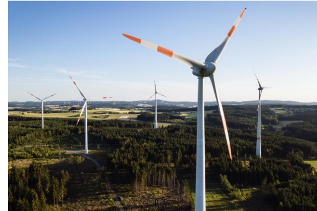
Mehrere Windenergieanlagen in Waldschadensflächen
