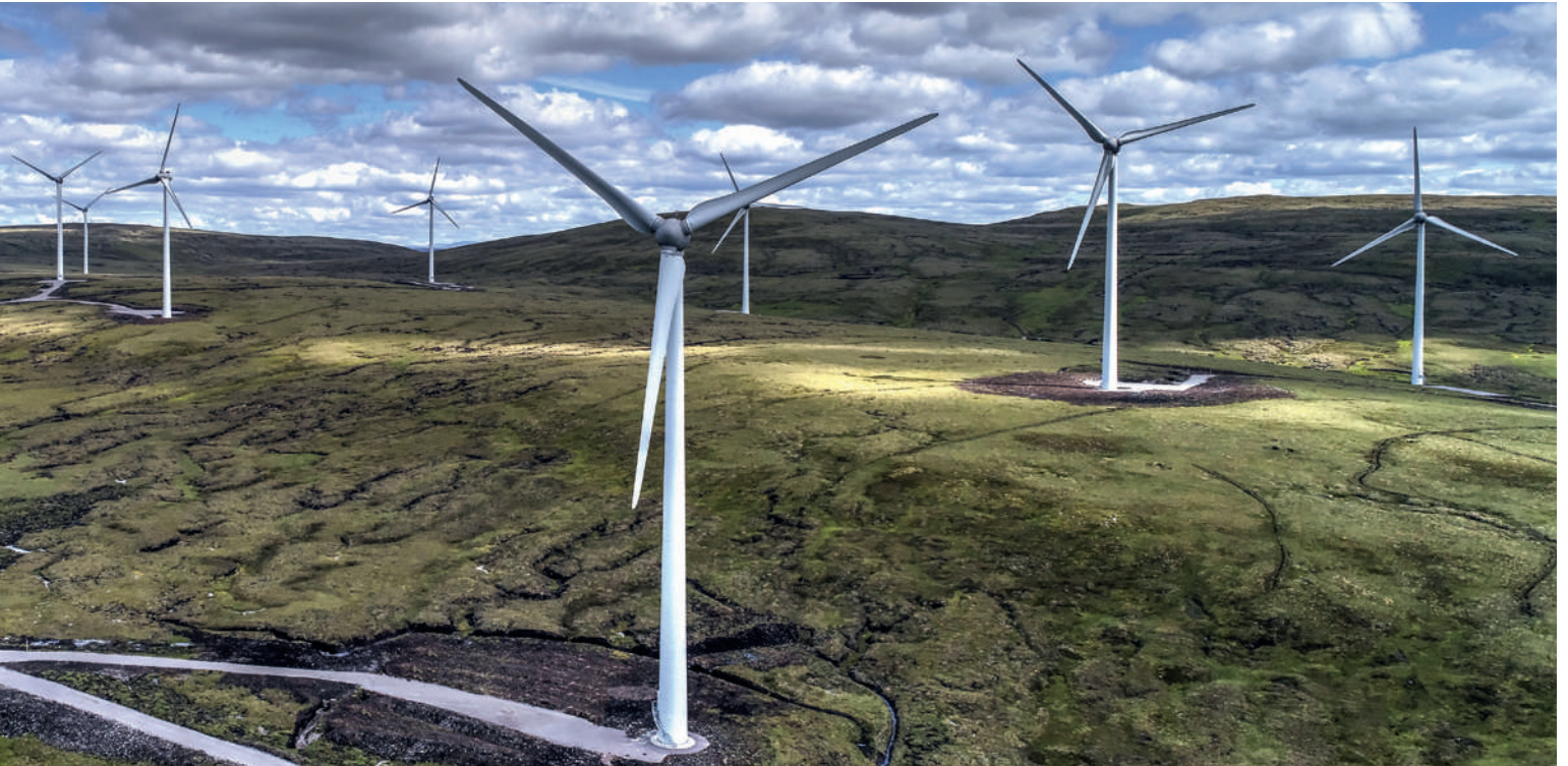
▲ Corriegarth Windpark in Schottland. Enercon konnte 2022 in Großbritannien 125 MW im Rahmen von nicht subventionierten Projekten installieren. Foto: Enercon
