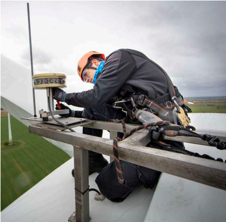
Ein Azubi von Enertrag Service wartet eine Enercon E-66 in Nechlin. Foto: Enertrag/Silke Reents
