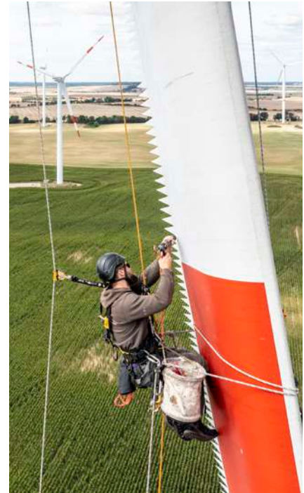
Industriekletterer im Windpark bei Pinnow. Industriekletterer montieren zusätzlich einen Kamm aus dreieckigen Zacken am Rotorblatt einer Windkraftanlage Repower 3.4 M 104 in luftiger Höhe. Die Nachrüstung soll Geräusche mindern, wenn die Rotoren sich drehen. Foto: Paul Langrock
